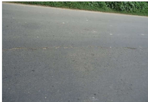
Fig.2. Longitudinal Cracking
